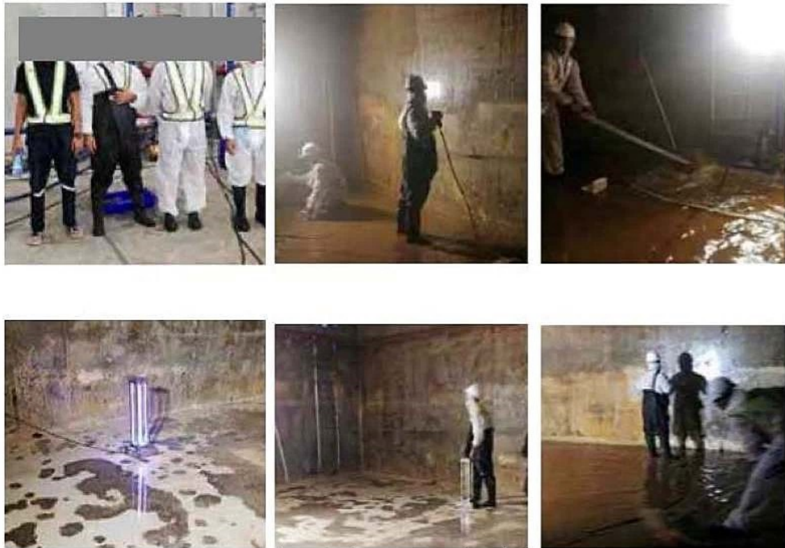
ภาพที่ 3-35 สร้างทำความสะอาดขอส้วร่อนน้ำใช้
