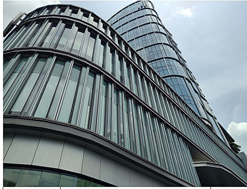
ภาพที่ 3-2 กระฉกที่ใช้เป็นกระฉกมีค่าการสะท้อนแสงต่ำกว่าร้อยละ 30
