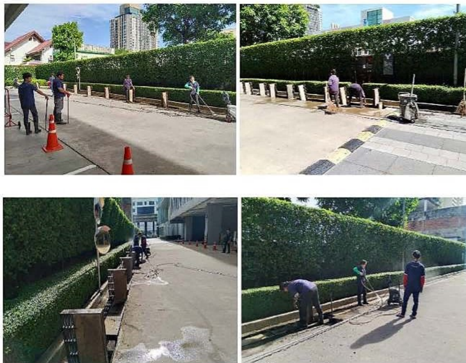
ภาพที่ 3-36 ขุดลอกทรายระบายน้ำและบ่อพักน้ำ
